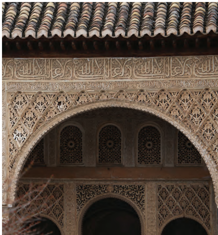
Slika 21.8. Detalji na vanjskom zidu palače Alhambra.
