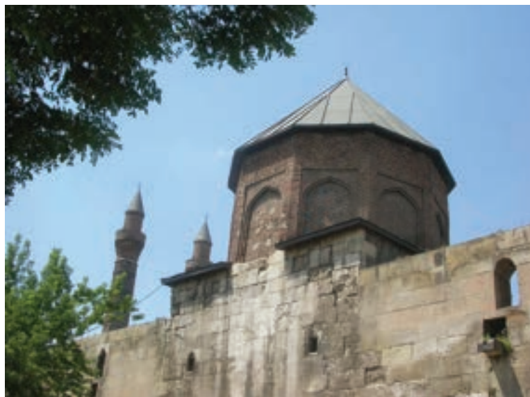
Slika 18.2. Medresa Sivas Şifaje sa svojom strukturom od 48x68 m, najveći je medicinski kompleks Seldžuka u Anadoliji. Sagradio ju je Izedin Kejkavus 1217. godine.
