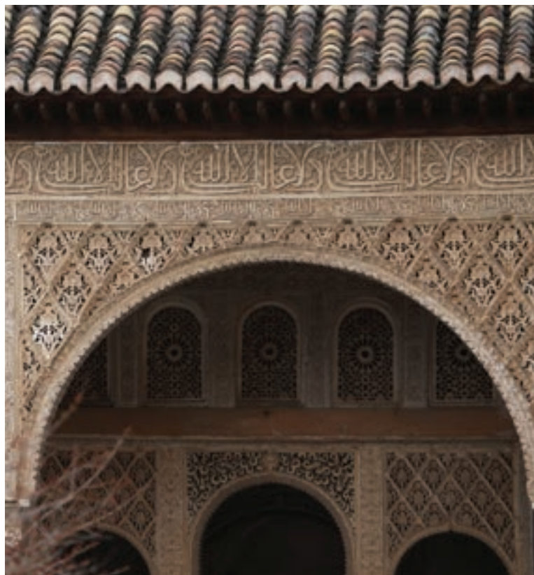
Slika 21.8. Detalji na vanjskom zidu palače Alhambra.
