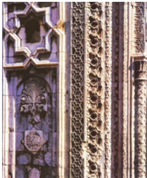
Slika 11.2. Ovaj detalj na ulazu u Gok Medresu koju je izgradio jedan od seldžučkih vezira Fahrudin Ali, prikazuje čuvenu rezbariju u kamenu anadolske seldžučke arhitekture. Sivas, 1271.
