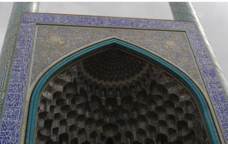
Slika 22.13. Mukarnas ukrasi na ulazu u Mesdžid el-Šah, Isfahan, Iran.
